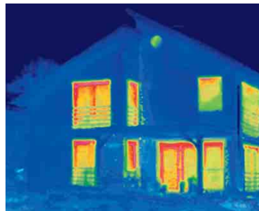
Infrarotaufnahmen, Thermografien, zeigen deutlich, wo ein Haus unkontrolliert Energie verliert. Rot bedeutet Wärme- und damit hohen Energieverlust.
