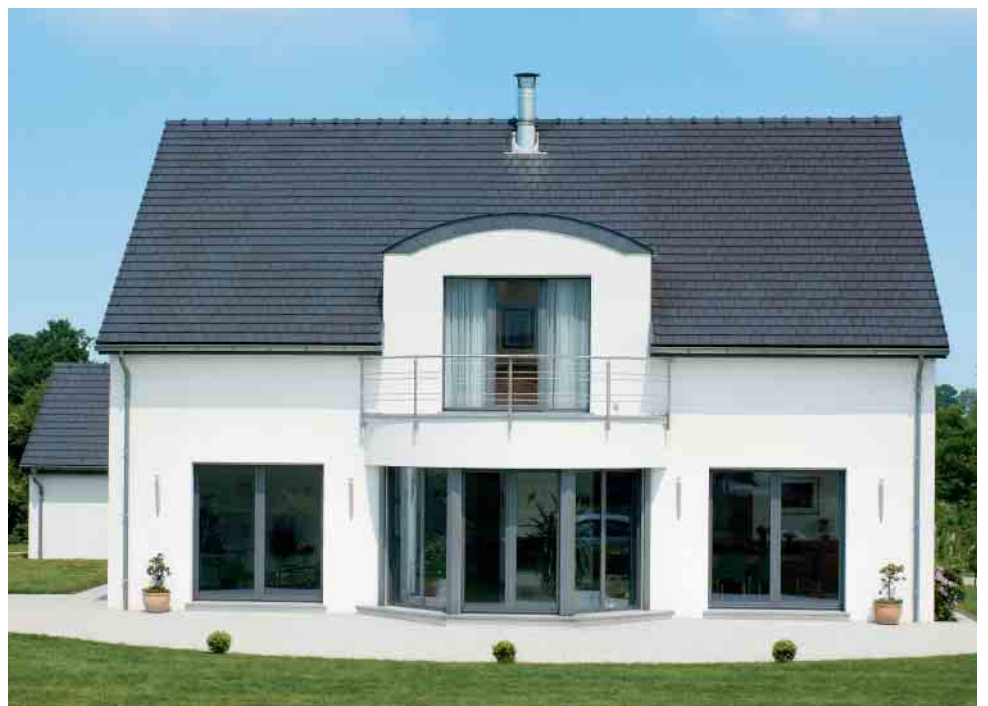
Fenster sind dominante Gestaltungselemente
